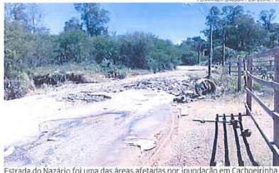
Estrada do Nazário foi uma das áreas afetadas por inundação em Cachoeirinha
